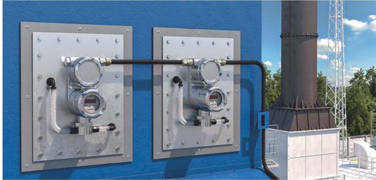
Воздушный поток направляет образцы воздуха вверх по впускной трубке, после чего образец воздуха попадает в колпак.
